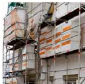
Réhabilitation d'un bâtiment communal en pôle santé à Aspres sur Buech (05) - FEADER
